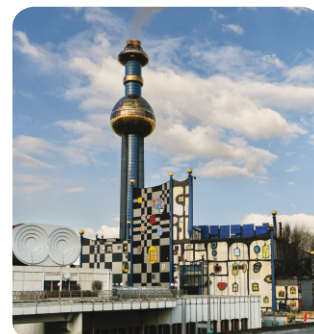
Spalarnia Spittelau, Wiedeń, Austria
