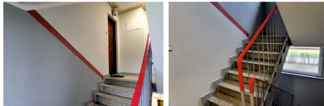
Klatka schodowa po kompleksowym remoncie w budynku przy ul. Skłodowskiej – Curie 133.
