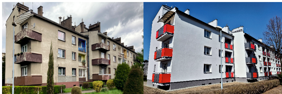
Budynek przy ul. Kosynierów 6 przed i po kompleksowej termomodernizacji przy wsparciu finansowym Banku Gospodarstwa Krajowego.
