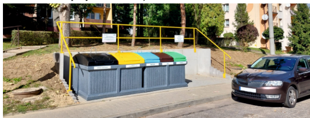
Śmietnik w systemie pojemników nadziemnych dla budynku na osiedlu Andaluzja 4a.
